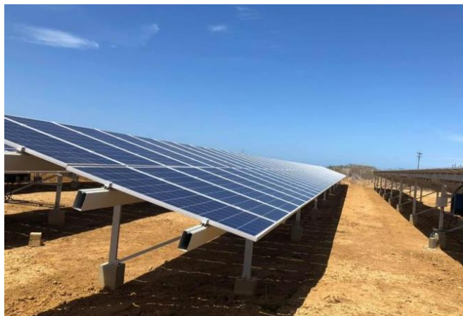
Imagen 2.2. a) Estructura de baja altura b) Estructura elevada. Fuente: IPSE
