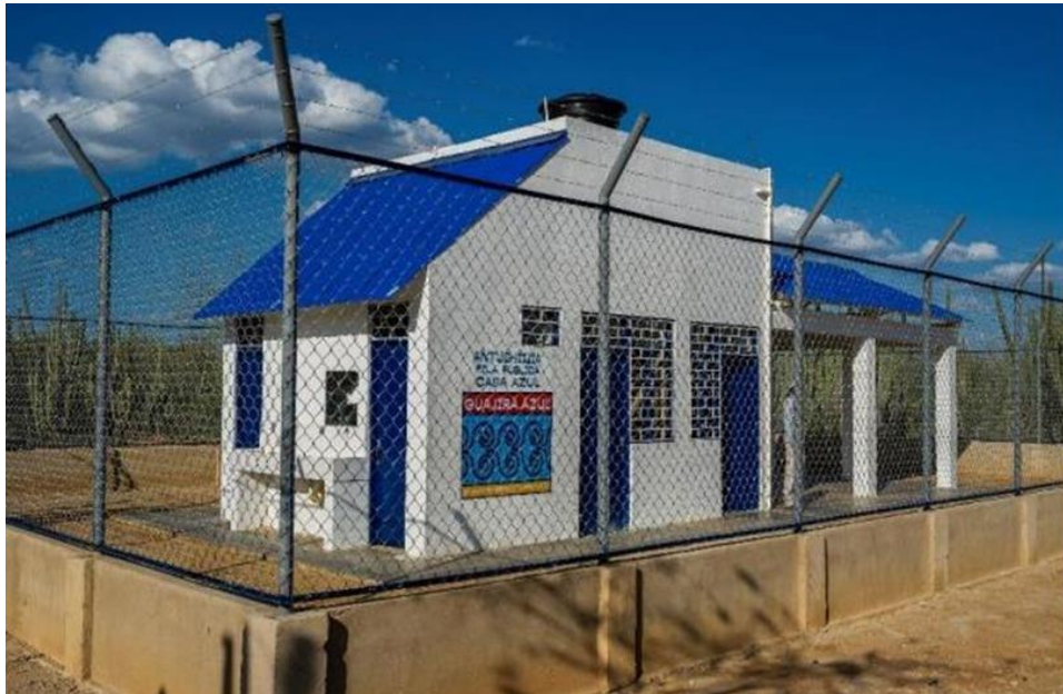
Ilustración 8. Proceso constructivo Pila Publica (Fuente MVCT)
