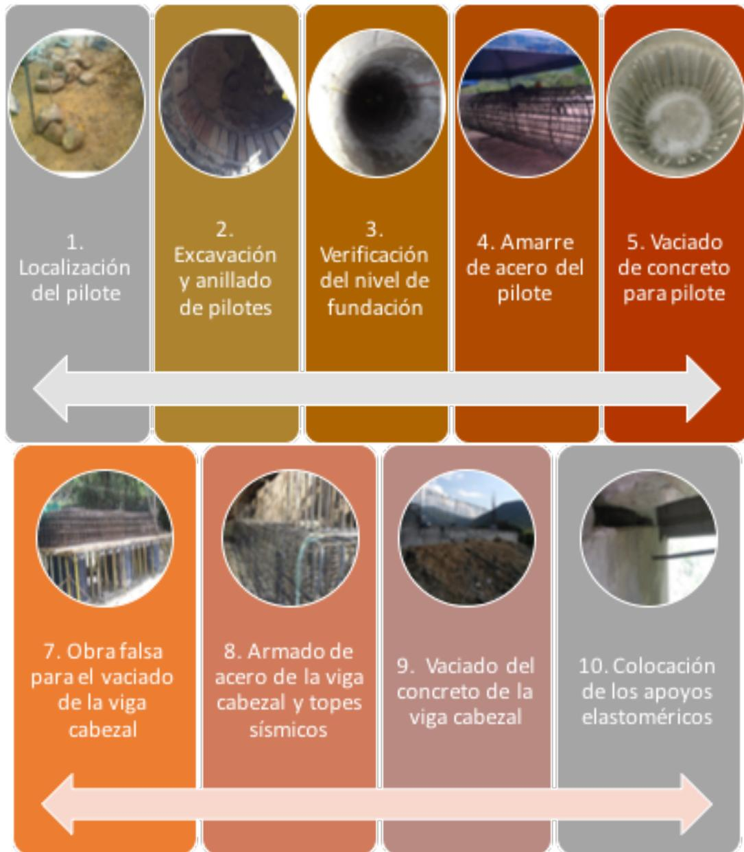
Ilustración 9 . Elementos del sistema de viga cabezal y pilas
