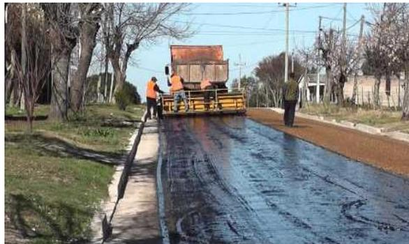
Fotografía 7 Proceso de aplicación de TSD.
