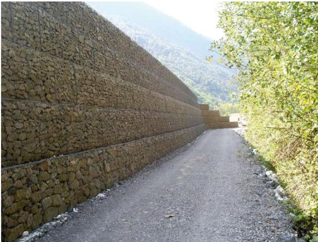
Fotografía 12 Muro de contención en gavión (Fuente: <http://www.civilexcel.com/2012/02/diseño-de-gaviones-muro-de-contención.html>)
