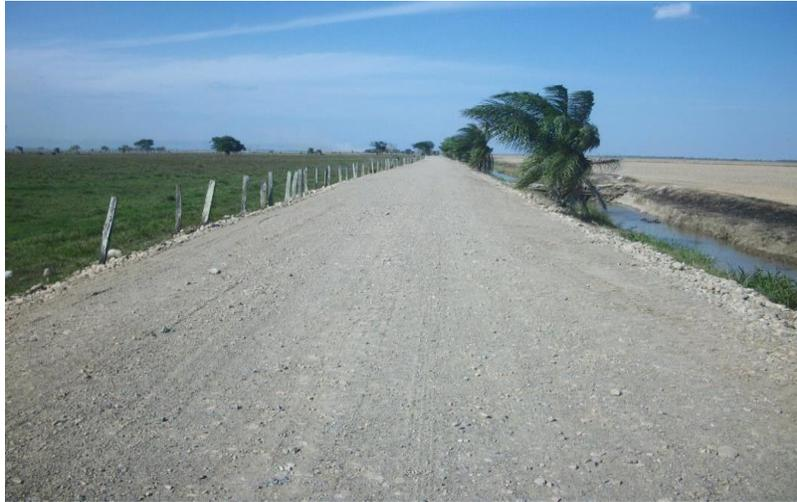
Fotografía 5 Proceso de estabilización mecánica con material granular
