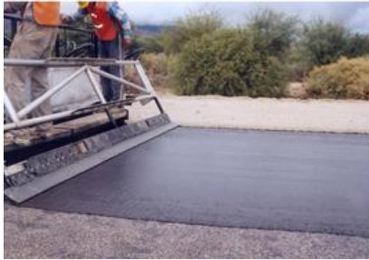
Fotografía 6 Proceso de aplicación de lechada asfáltica.
