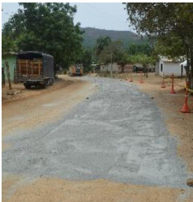
Fotografía 3 Proceso de estabilización con cemento (Fuente: Archivo DNP)
